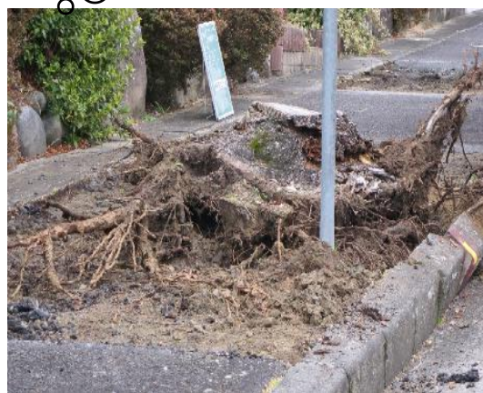
2. 抜根(根の塊を撤去)
