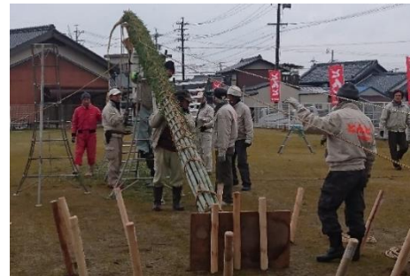
②12本の芯棒を縄で巻き、保存会のメンバーで三方から引っ張り芯棒を起こし、円錐形の小屋を建てる。
