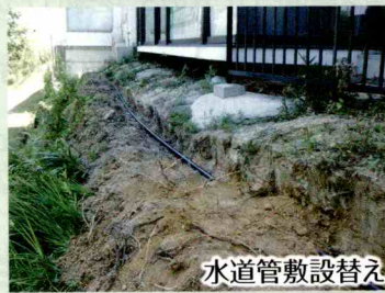
トイレ給水管工事
