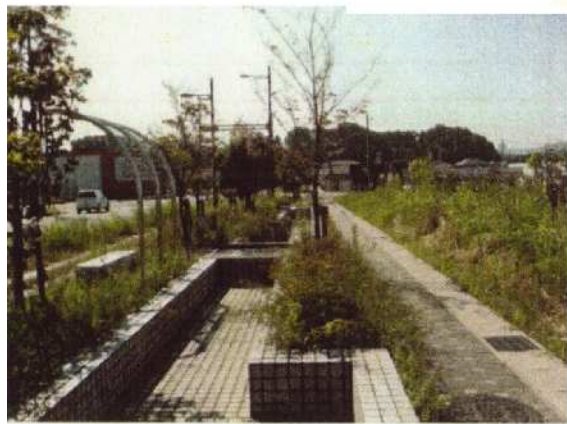
せせらぎ水路
